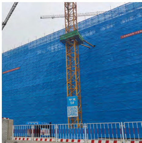
塔吊附着部位
