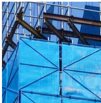
网片拼缝不严密， 超过10mm
