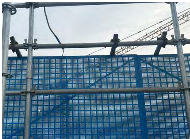
钢板网设防坠措施
